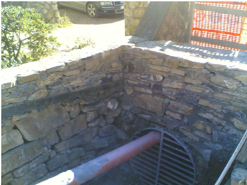
**Figura 8 Innalzamento delle quote spondali in prossimità del tombino di attraversamento**
